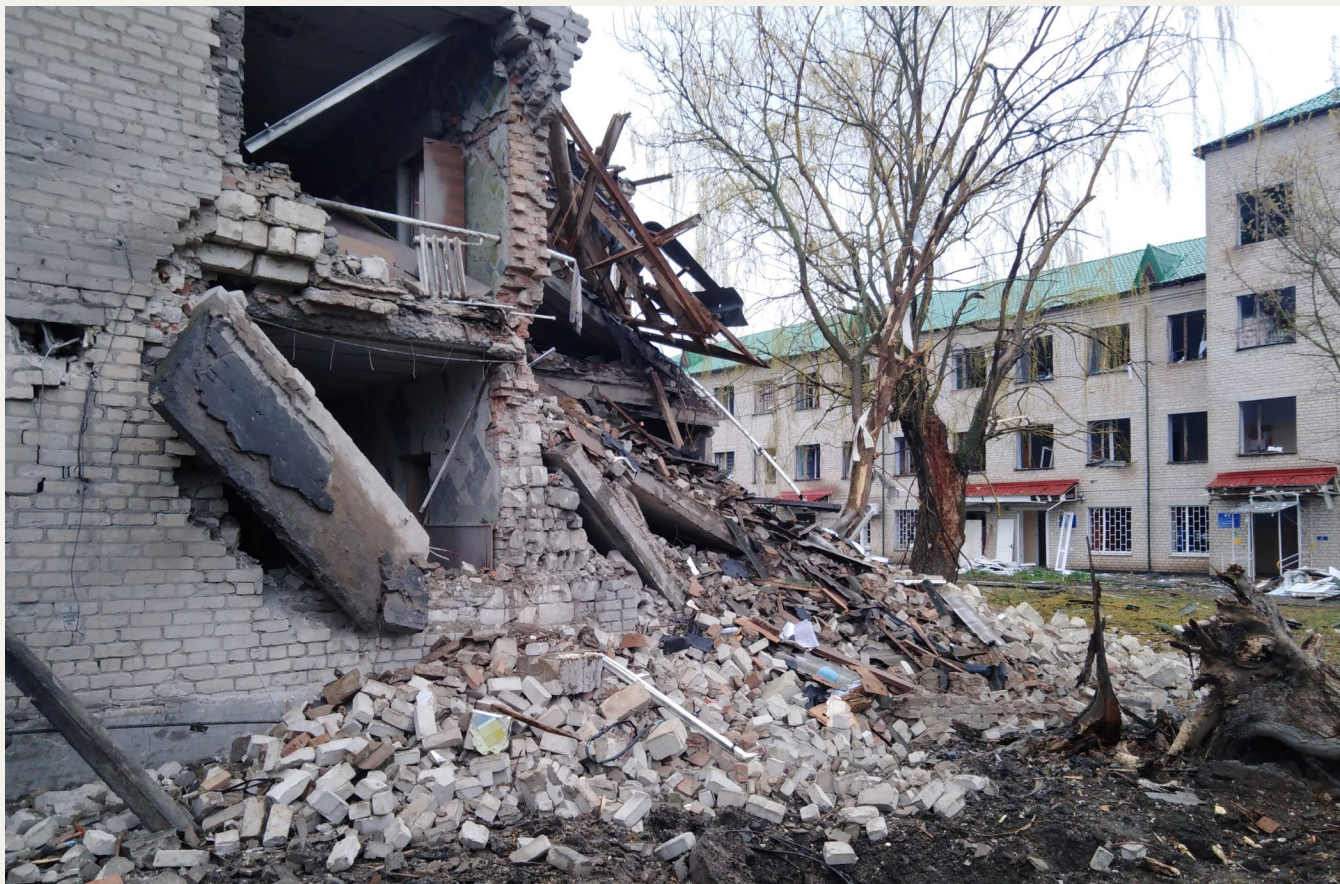
Ракетний обстріл Баштанської багатопрофільної лікарні повністю зруйнував будівлю поліклініки. Фото зроблено медичними працівниками лікарні у квітні 2022 року.
